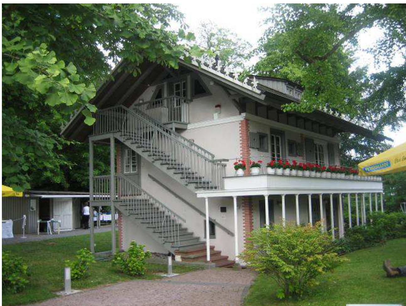
... mit dem umlaufenden Balkon an den beiden Hauptseiten...
